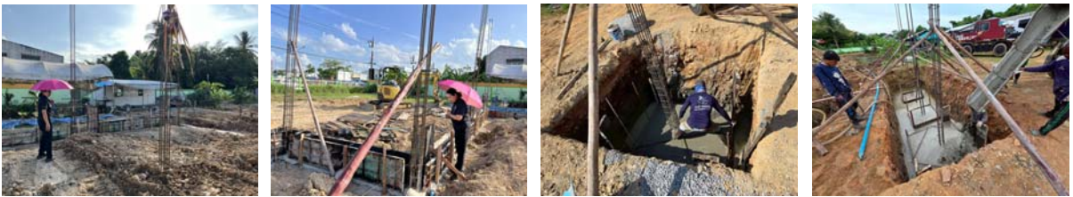
ภาพที่ ๕ ทัศนคติหน้าการก่อสร้างอาคารสำนักงานเกษตรอำเภอดอนสัก มติที่ประชุม รับทราบ
